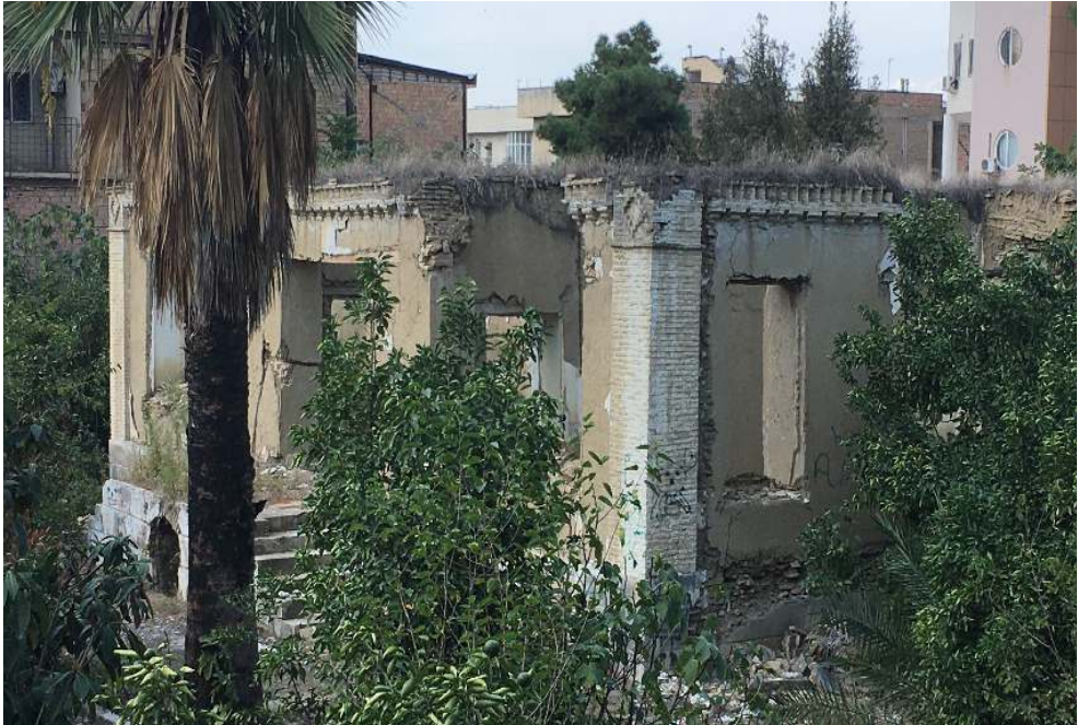
نمایی از بقایای ساختمان کوشک خانه تاریخی یزدی - ۱۴۰۴ خ
